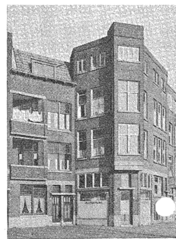
Gevels te Z. waterdicht gemaakt met Hamoline
