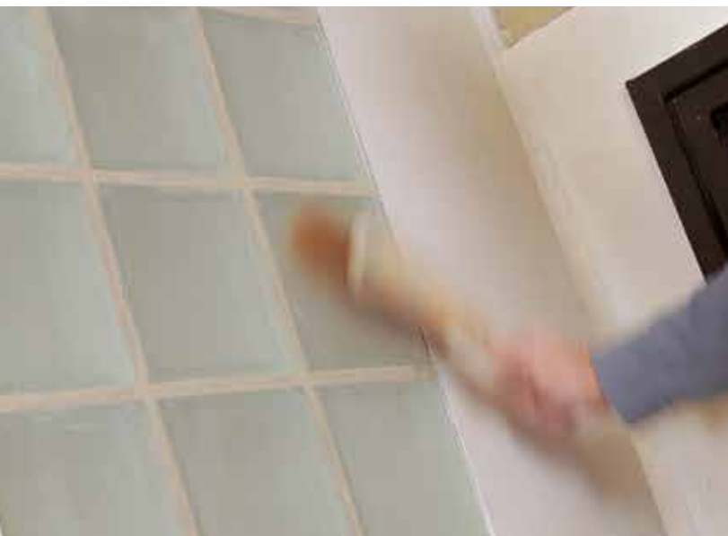
[Fig 24] Aansluiting van glazen bouwsteen aan metselwerk
